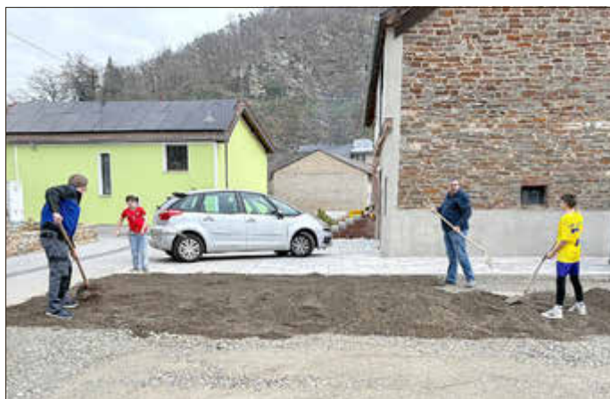
Vorbereiten des Untergrunds.
